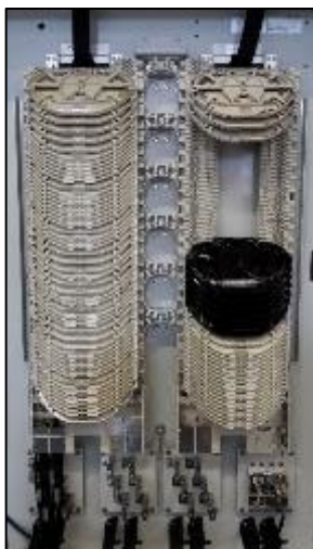
Abbildung 16: Gf-NVt 10gr Spleißbereich Abbildung 17: Gf-Koppler 1:32 Corning
