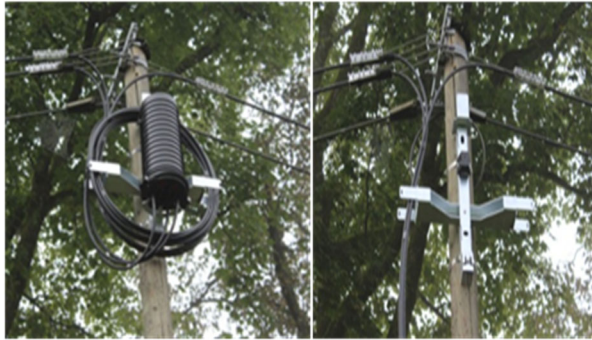
Abbildung 90: Mastkreuz/Überlängenkreuz mit und ohne Gf-Muffe
