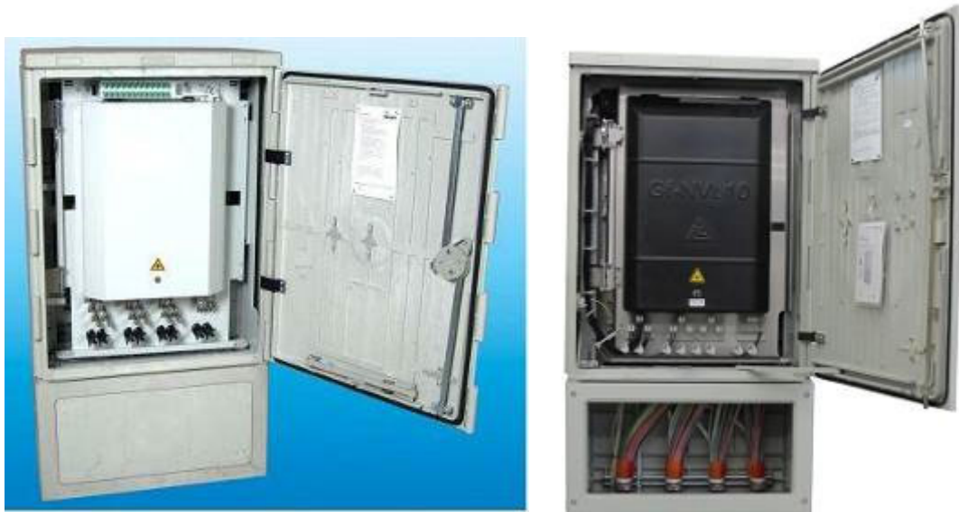
Abbildung 10: Gf-NVt geschlossener Spleißbereich
