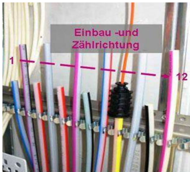
Abbildung 31: Einbau-und Zählrichtung
