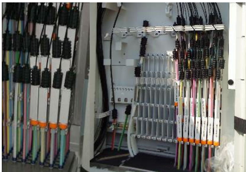
Abbildung 14: Beschriftung und der Belegung Bodenplatte
