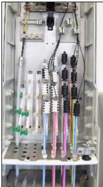
Abbildung 52: Gf-NVt 17xs (RA) Absetzmaß SNR7 Firma Langmatz
