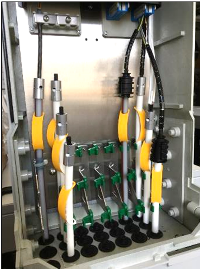
Abbildung 68: Gf-NVt 17xs (BF) SNR-/Gf-Minikabel-Bereich
