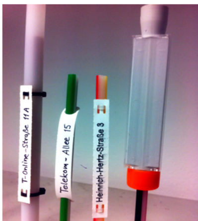
Abbildung 19: Beschriftung Gf-NVt
